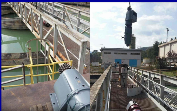
Lavori di manutenzione presso impianto trattamento acque Macchia di Ferrandina (MT) - CSI della Provincia di Matera
