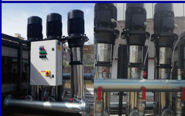
Fornitura e installazione gruppo pompe di pressurizzazione Stadio San Ciro - Comune di Portici (NA)
